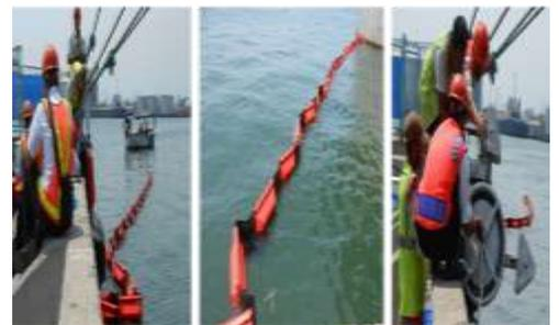
Gambar 5 Pemasangan Oil Boom
